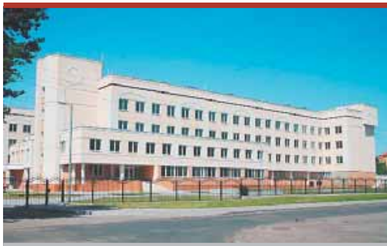
Калининград, региональный перинатальный центр
