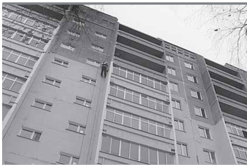
После отделочных работ дом будет как новенький
