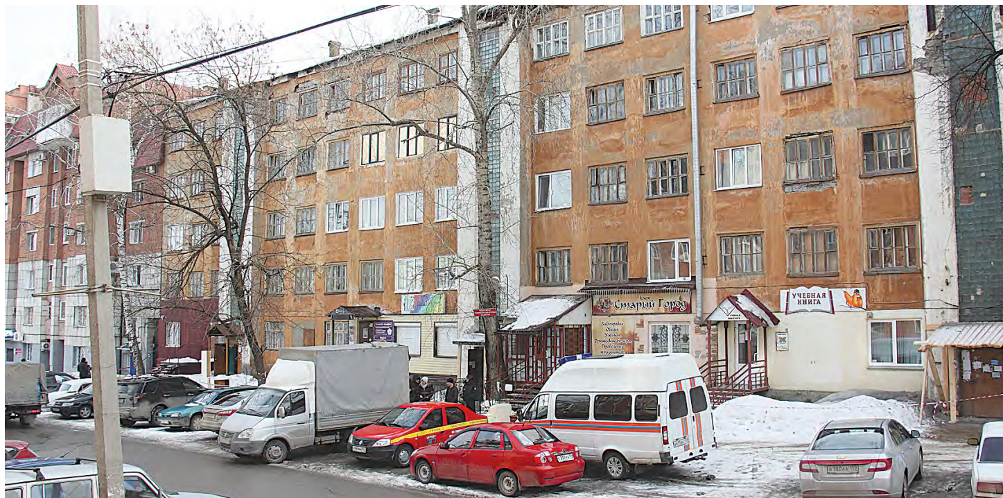
Дом № 14 на ул. Петропавловской был построен в 1934 году, признан аварийным в 2014-м
