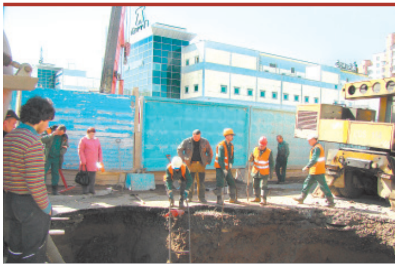
А кто застрахует жителей соседних домов, возместит убытки города за простой строительства коллектора?
