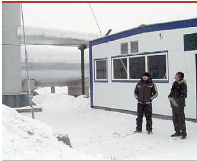
Частная котельная исправно работает, но денег за работу не получает
