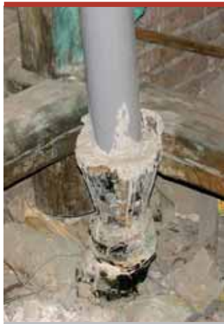
Трубы горячего и холодного водоснабжения цементировали в чужинные трубы 1936 года. Вот такой капремонт сделан на федеральные деньги в Перми
